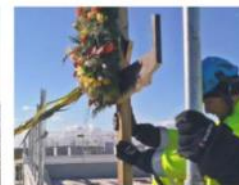
24-10-2018 Zakończenie montażu budynków
