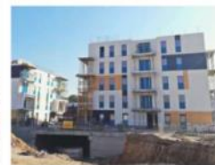
12-10-2018 Montaż ostatniej kondygnacji
