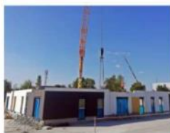
22-08-2018 Rozpoczęcie montażu budynków
